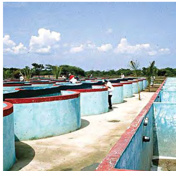
Figura 46. Infraestructura requerida para crecimiento de cocodrilos. Foto: Gustavo Casas Andreu.
